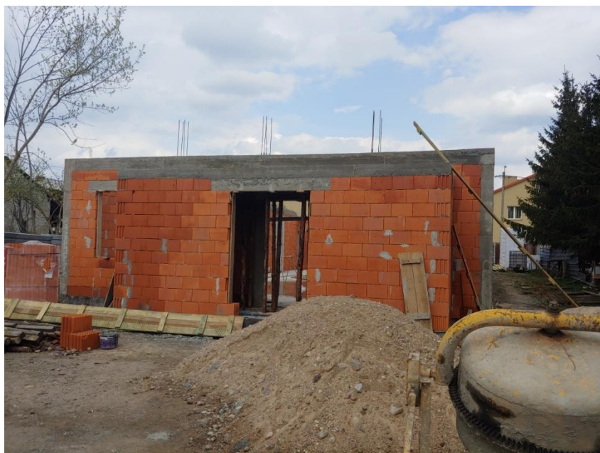
Obiekt Centrum Rozwoju przedsiębiorczości w trakcie budowy
