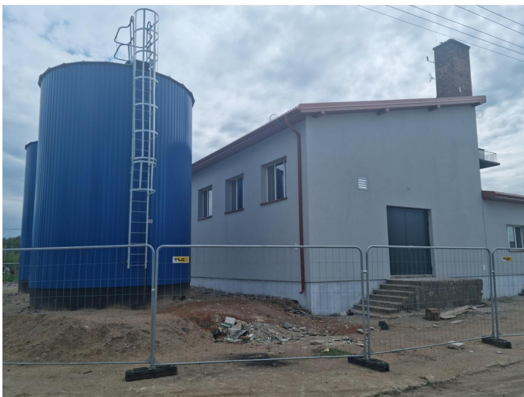
Przebudowywana Stacja Uzdatniania Wody w m. Szczuczyn
