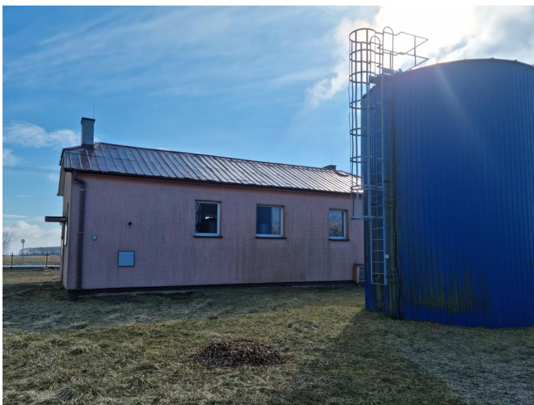
Stacja Uzdatniania Wody w miejscowości Niedźwiadna (obecnie)
